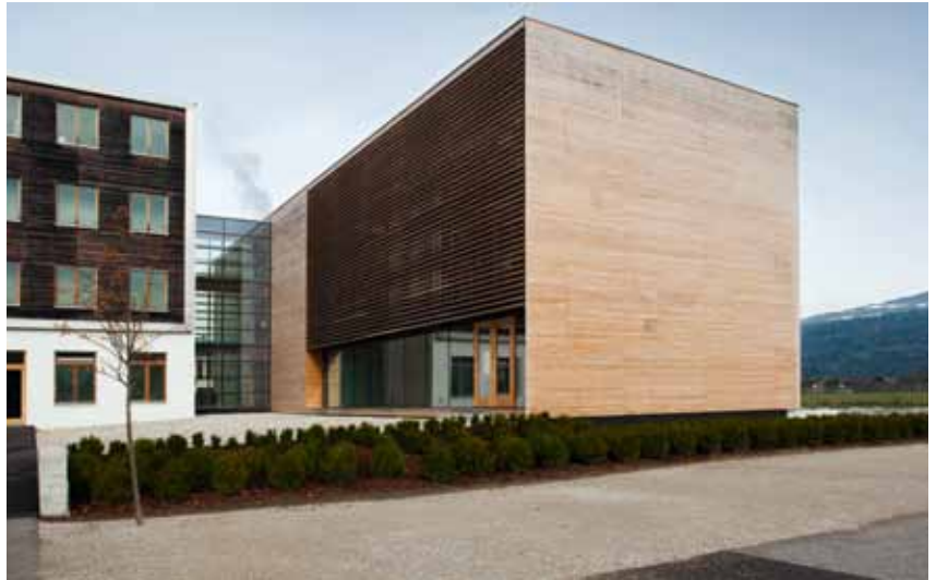
Campus Kuchl: Zubau ist erster universitärer Holzbau in Passivhausstandard
