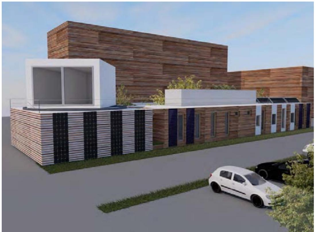
Der Studiengang Smart Building der Fachhochschule Salzburg errichtet am Campus Kuchl ein Versuchsgebäude mit Prüfstand für die In-situ- sowie Langzeitmessung von Fassadensystemen und gebäudetechnischen Anlagen.
